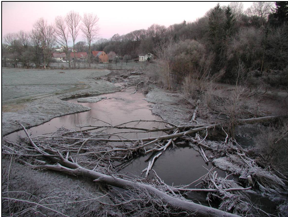
Abb.15: Renaturierter Abschnitt der Alme mit Gerinneverzweigung und Totholzeinbau (Foto: WOL)
