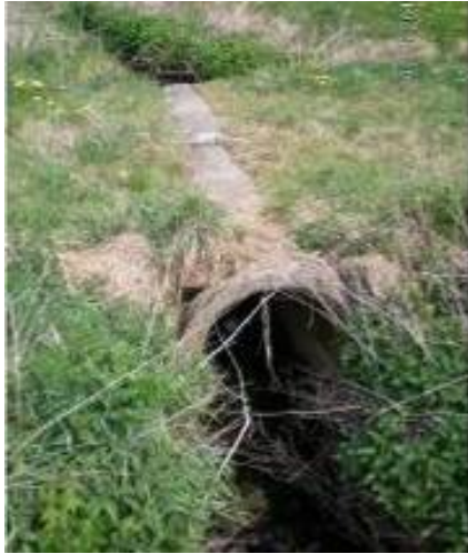
Abb. 2 (links): Überfahrt als Rohrdurchlass (Bach von den Erlenwiesen; Foto: A. Plewka, Stadtwerke Brilon), Abb. 3 (rechts): Anlage einer Furt (Foto: NZO-GmbH)
