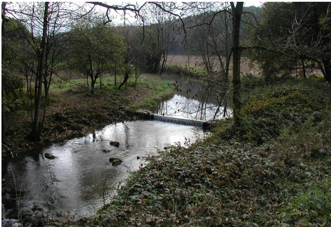
Abb. 20: Sohlabsturz vor der Renaturierung an der Altenau (Foto: WOL)
