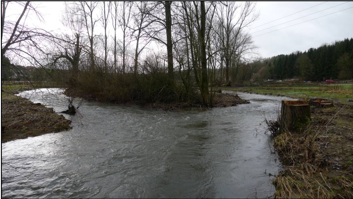
Abb.16: Anlage von Gerinneverzweigungen an der Alme unterhalb von Weine (Foto: WOL)
