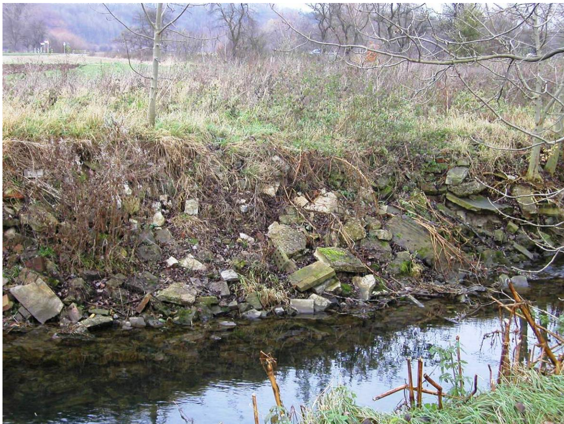
Abb. 11: Bauschutt an einem Gewässerabschnitt der Alme (Foto: WOL)
