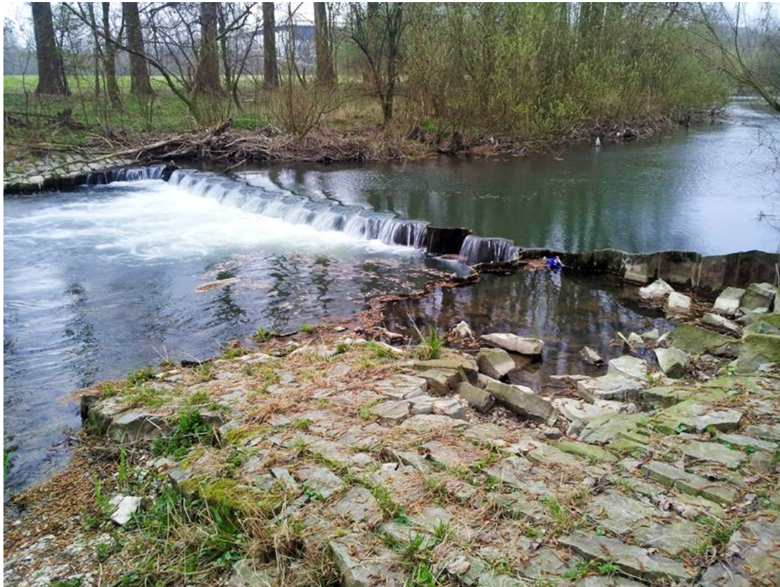
Abb. 14: Sohlabsturz und Uferbefestigung an der Alme im geplanten SU 1 (Foto: NZO-GmbH)
