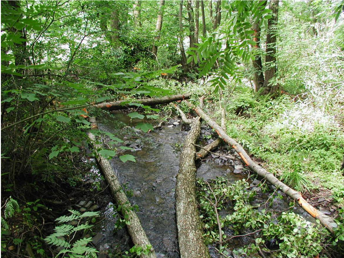
Abb. 38: Totholzeinbau am Aabach (Foto: WOL)
